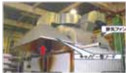
配管含めた送風機 設置工事 設計・施工
